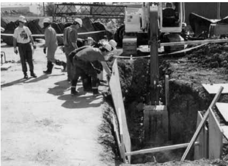
Actual trench rescue April 2010
